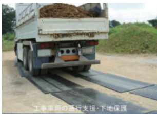
工事車両の通行支援・下地保護
