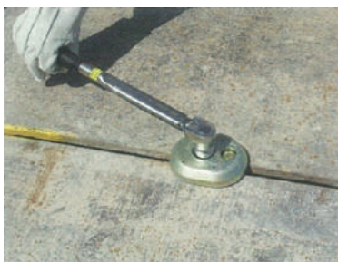
④小判君の上部をかぶせ、締付ボルトを締めます。(規定トルク：120N/m)
