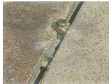
③2枚目の敷鉄板を設置します。
