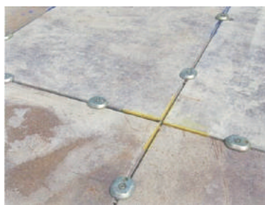
⑤取付完了。見た目もスッキリ。頑丈で安全です。
