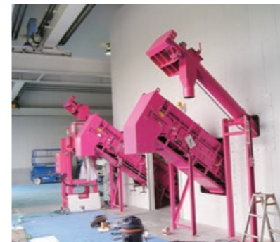
10 カレット搬送コンベヤ
