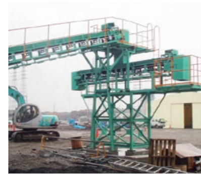
4 解泥土壌設備
