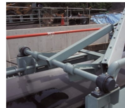
11 中間払出装置
